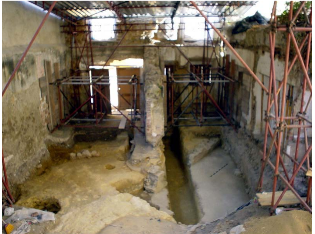
Figura 9 Fotografia geral da área intervencionada em 2003/2004.
