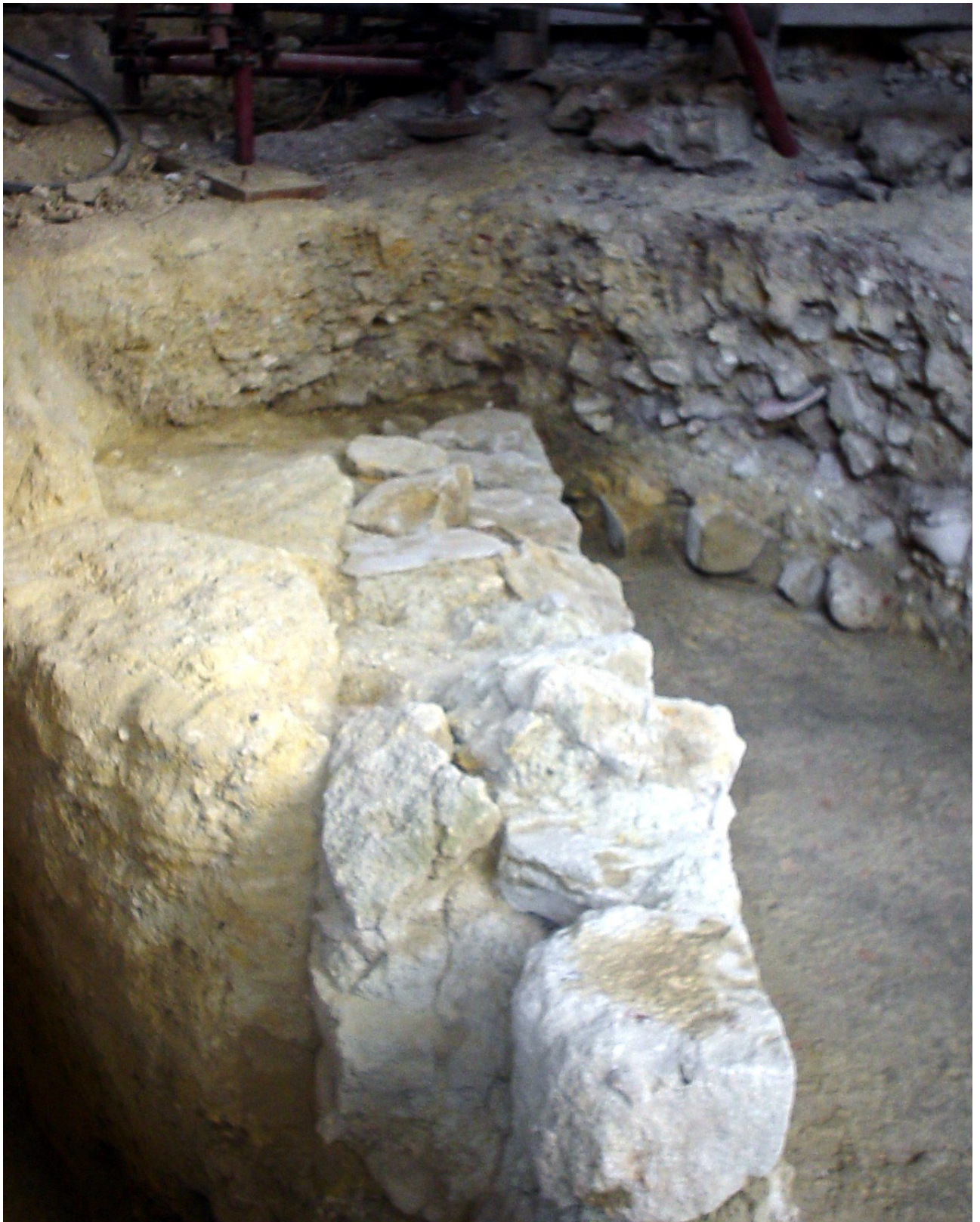
Figura 16 Fotografia da área intervencionada em 2003/2004, sendo visível em corte o nível de colapso da parede.
