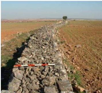
Figura 14 Muro perimetral del recinto mayor el complejo militar de El Pedrosillo (Fotografía: A. Morillo)
