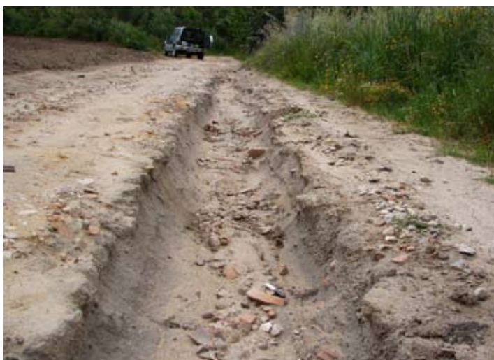
Figura 3 Vista geral dos terrenos no início dos trabalhos.
