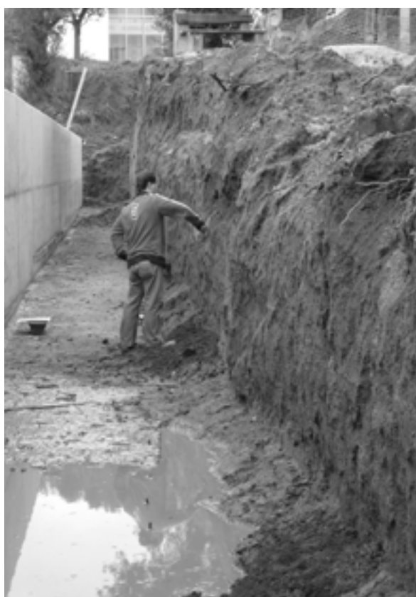
Fig. 3 Pormenor do corte depois de limpo.
