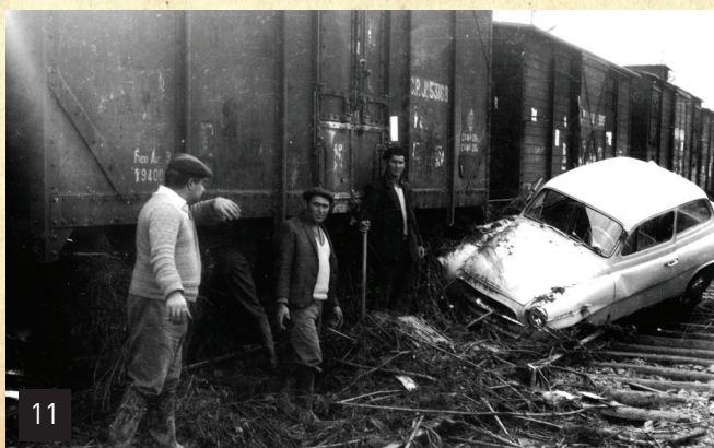
[11] Inundações junto à linha de caminho de ferro
