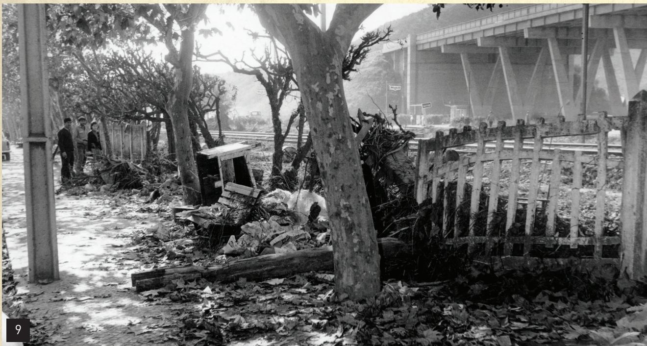
[9] Inundações junto à linha de caminho de ferro
