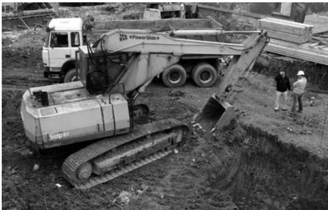
Fig. 4 Fotografia do início dos trabalhos.
