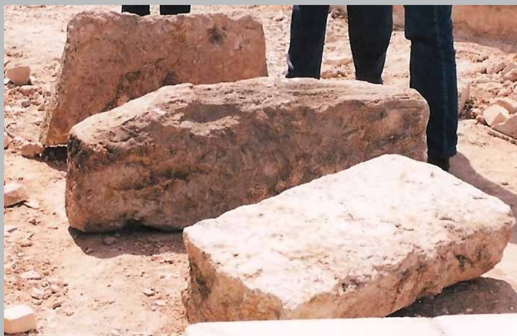
Fig. 2 - Pedras pertencentes aos degraus antes da intervenção. Foto Paula Monteiro, 2001.
