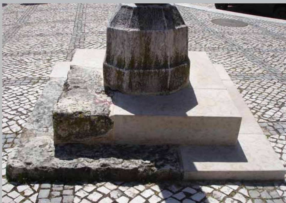
Fig. 4 - Base e degraus após intervenção. Foto Ana Libório, 2010.
