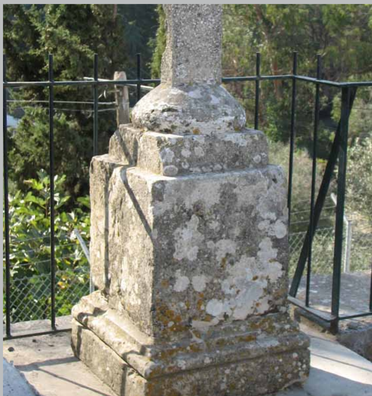
Fig. 11 - Cruzeiro de S. João dos Montes. antes da intervenção. Foto Ana Libório, 2007.
