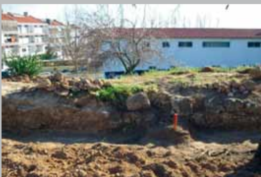
Fig. 9 - Muro sul colocado a descoberto em inícios de 2010 (GOMES, F.)
